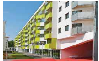
Wohnanlage Kaisermühlenstraße, Wien. FOTO: TREBERSPURG & PARTNER ARCHITECTEN
