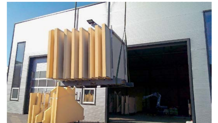
Passgenau von der Produktionsanlage auf die Fassade: die Module von Winterface.
